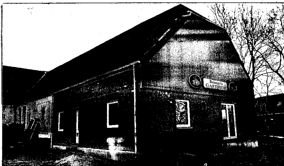
Der Anbau als Altersruhesitz für Ellen und Manni Foto: W. Müller, 2013
