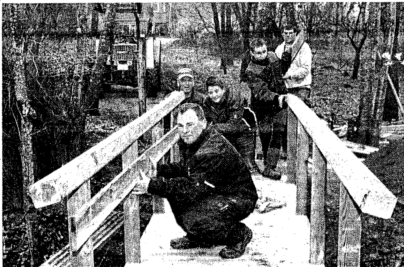
Die „Hollingstedter Fenne“ ist durch die Brücke wieder sicher zu erreichen.
