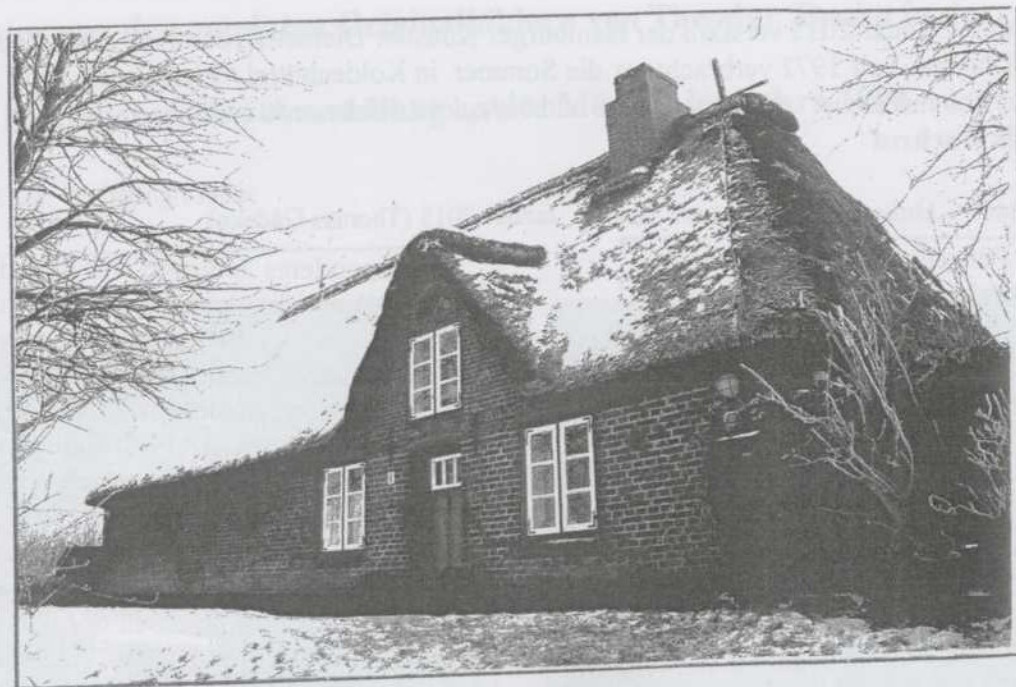
Das Wohnhaus von Diether Kressel in Koldenbüttel/Herrnhallig
